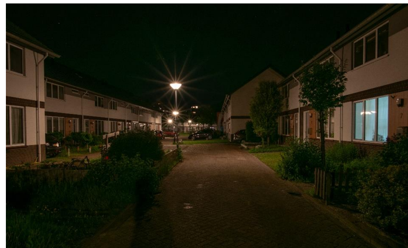
Oude rondstralende verlichting: donkere plekken op de weg en veel licht op de gevels
